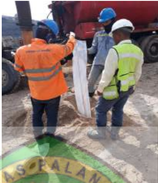
Gambar 4.3 Pemasangan Plastic Liner
